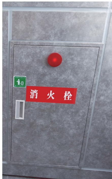
施工例(2号消火栓)
